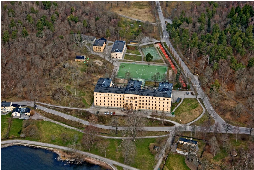
Flygbild: Skolområde Campus Manilla. Statens fastighetsverk, 2014.
